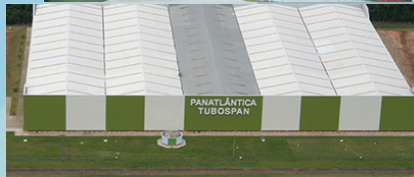
TUBOSPAN São Francisco do Sul/SC
